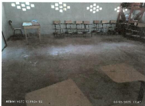
Foto1: Se realizara instalacion de piso en las a las aulas y corredor del INEB.
